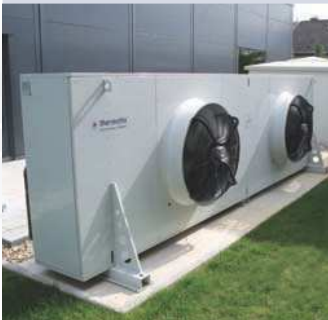
Externer Verflüssiger für externen Kühler
